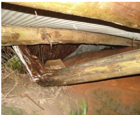
窯厝傾倒，大樑側壓窯龜
